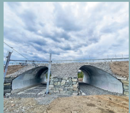
MP200 underganger og trafikk tunneler
