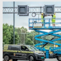
Montering av infrastruktur
