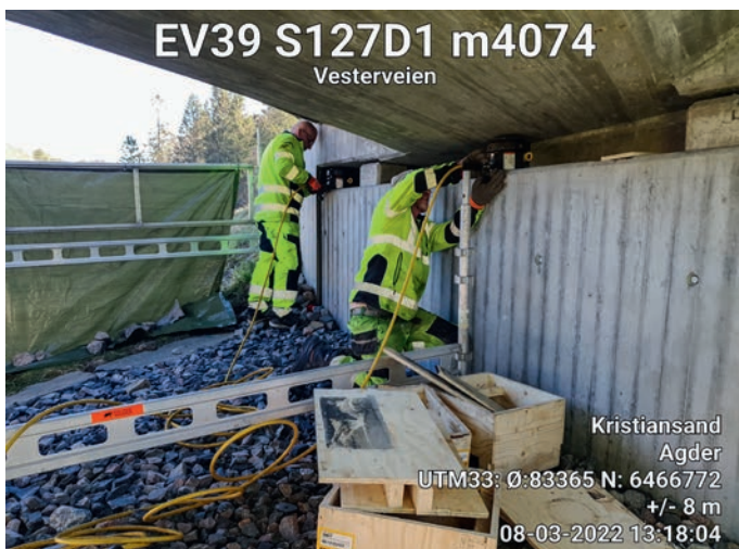
Firmaet i gang med bruarbeid på E39.
