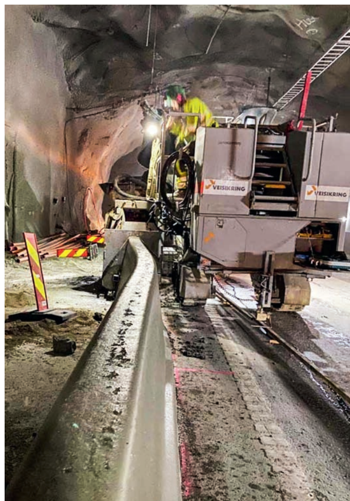
Veisikring betongrekkverk på stedet i Borgundtunnelen på E16.
