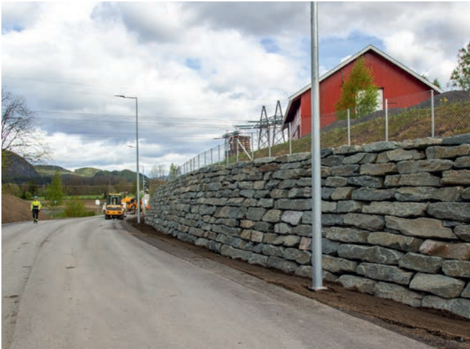
På nordsiden av nybrua: Lekker støttemur.
