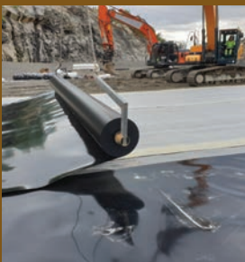
Geomembran – levering og montering
