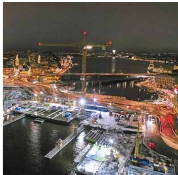
Fra T-banestasjonen i gamlebyen til Kornhamnstorg går ca. 500 meter med SoundGuard, en skallsikring som er beregnet for både anleggsområdet og trafikantene.
