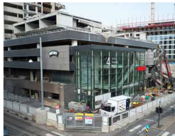
Byggeprosjekt i Oslo sentrum, der byggene beskyttes ved hjelp av GP Link og SoundGuard.
